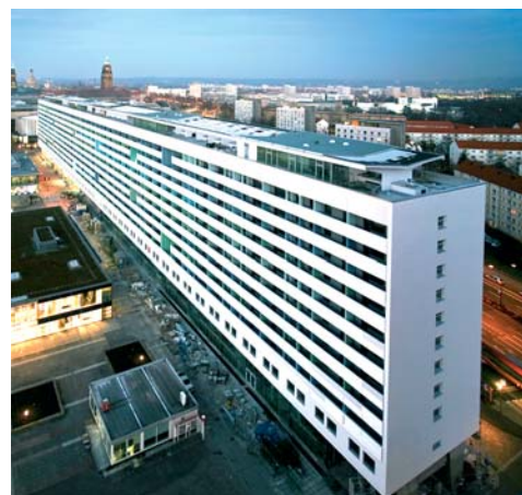
Das längste Hochhaus Europas – Die Lange Zeile Prager Straße nach ihrer Sanierung
