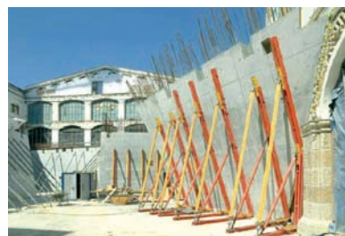
komplizierteste Verschalungen für Sichtbeton
