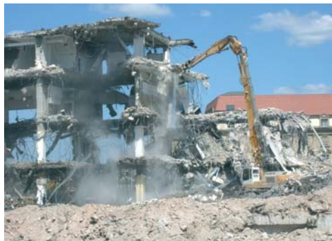
Abriss des früheren Warenhauses
